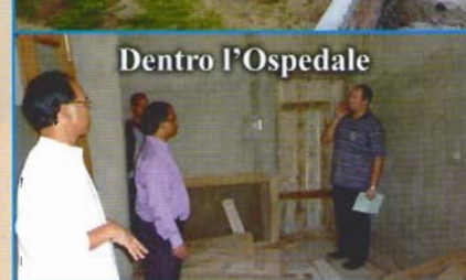
Interno Ospedale di UMDEN
